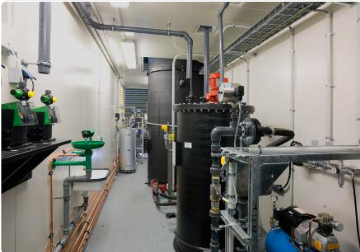
Bild 1: Die gesamte Steuerung der komplexen Anlage wird von einem Nano-box PC mit dem Software Controller WinAC bewältigt.
